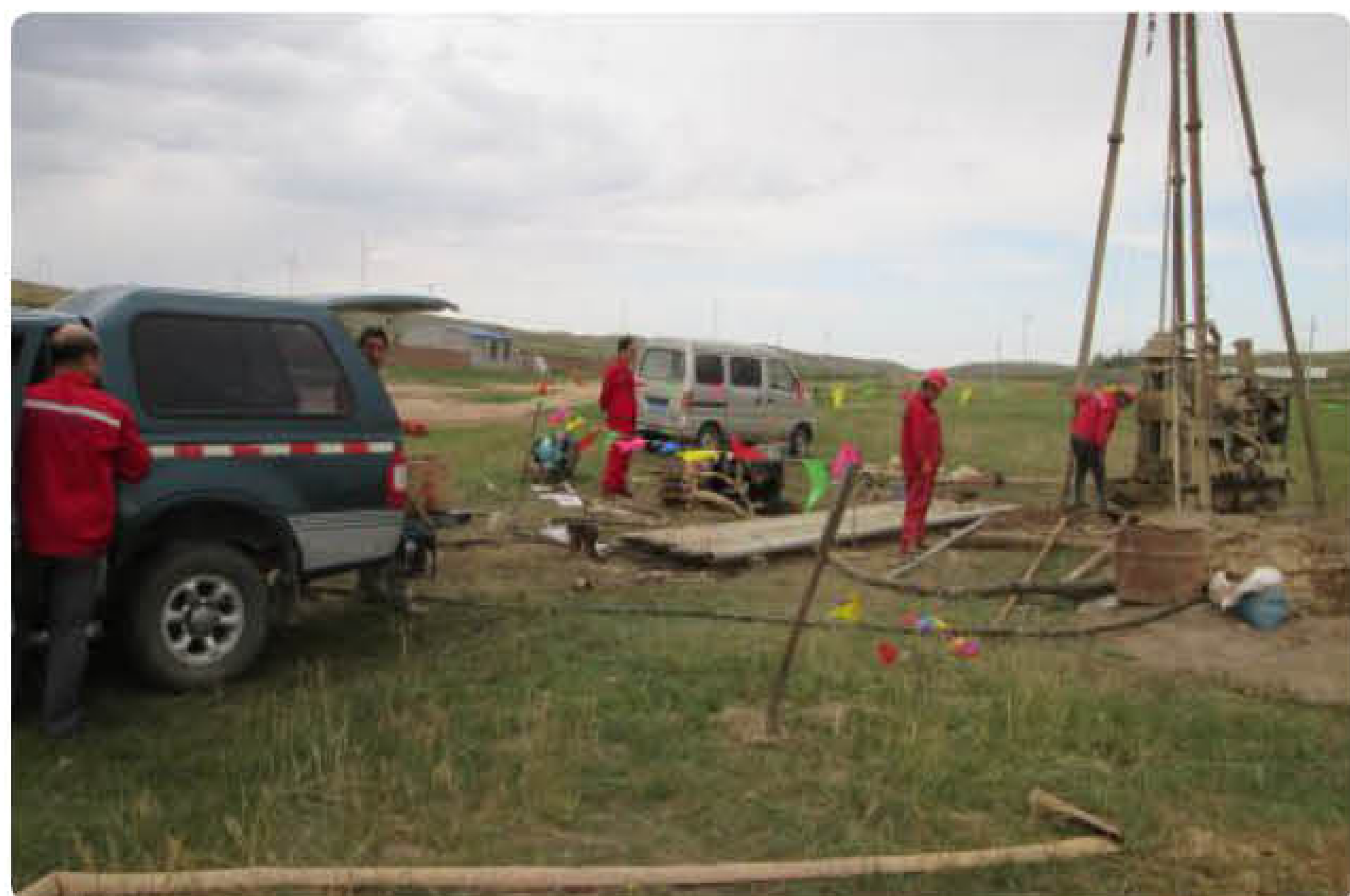
探采结合井施工现场
